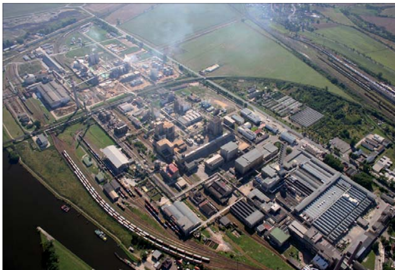
Letecký pohled na Lovochemii.
