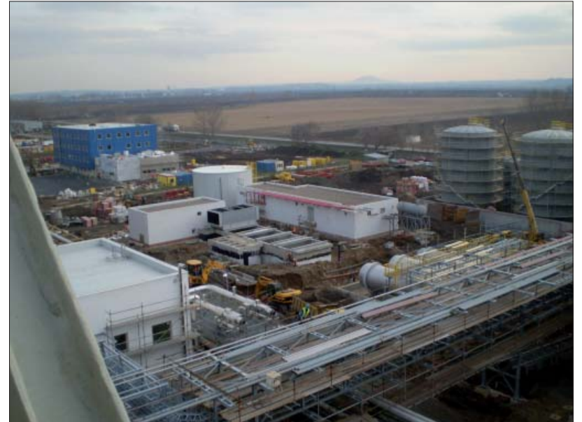
Celkový pohled na staveniště.
