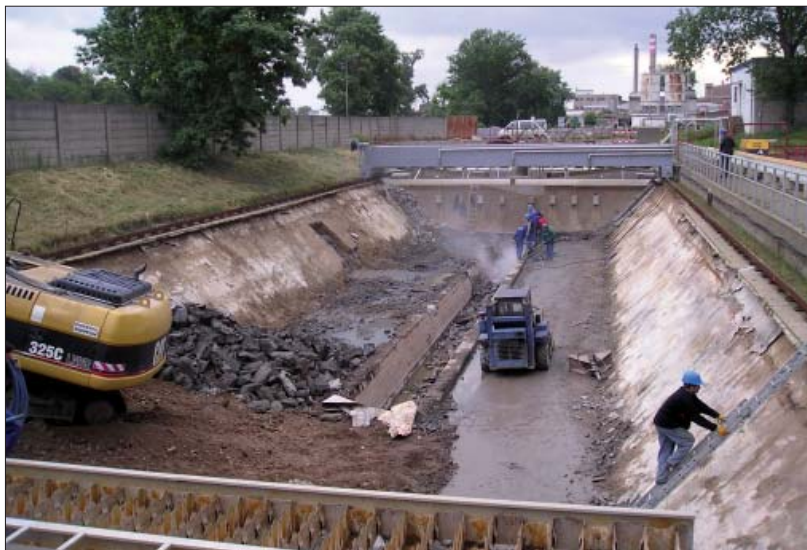
V tomto měsíci již byla zahájena oprava sedimentační nádrže na čistírně odpadních vod. Foto: Miroslav Kraut
