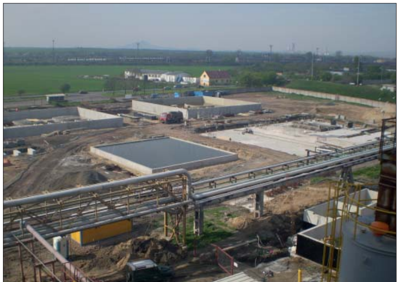
Základy budov jsou již dokončeny.
