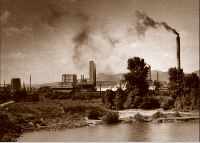
Pohled z východu.
