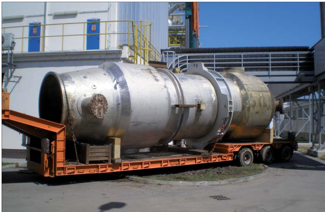
Demontáž a příprava výměníku E 3310 v Lovochemii k opravě do výrobního závodu. Hmotnost výměníku je asi 40 tun.
