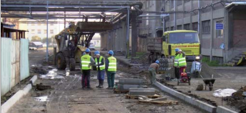
V těchto dnech probíhá oprava silnice a přejezdů mezi hlavním skladem a úpravnou vody. Foto: Miroslav Kraut
