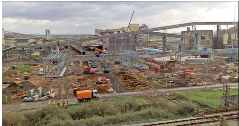
Severní část staveniště.
