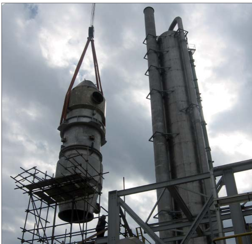
Demontáž výměníku KD6 s pomocí jeřábu.
