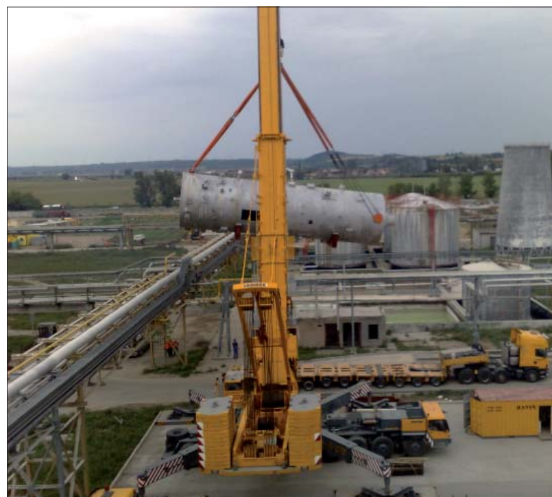
Doprava zařízení přes potrubní most u výroby NPK.
