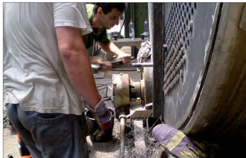
Trubky výměníku E3310 byly nahrazeny novými.
