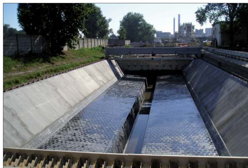
Sedimentační nádrž po opravě.
