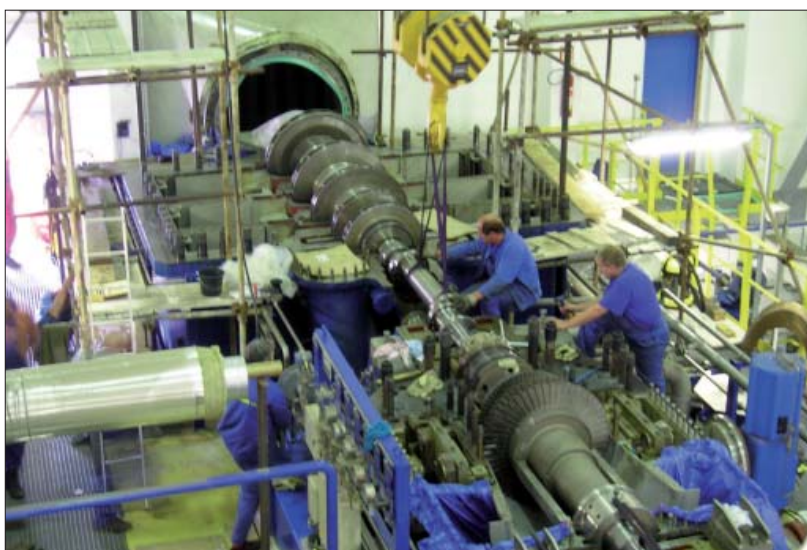
Práce na revizi turbosoustrojí KD6.
