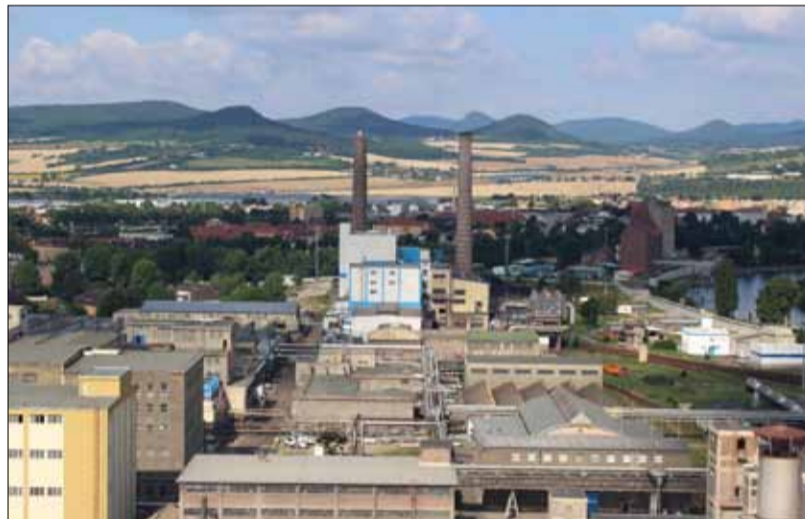
Objekt energetiky, pohled z kolony KD6.
