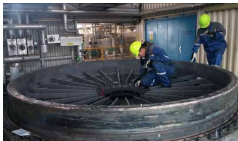
Práce na kotli KD6.
