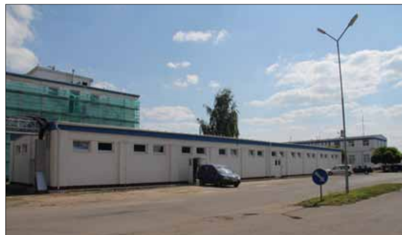
Úložiště písemností po rekonstrukci.
