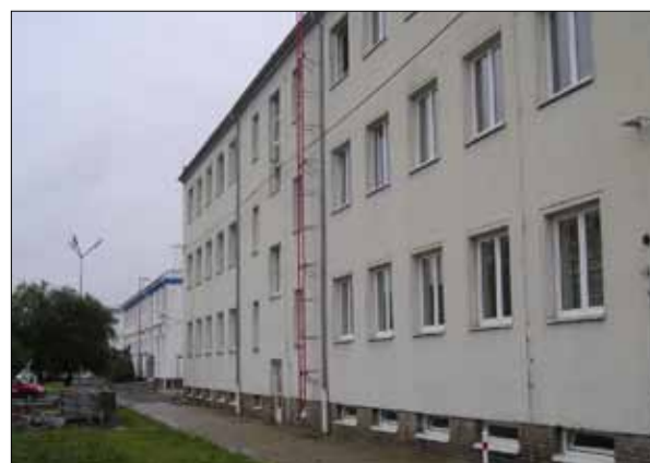
Původní stav budovy u vrátnice, v pozadí opravená budova OR.
