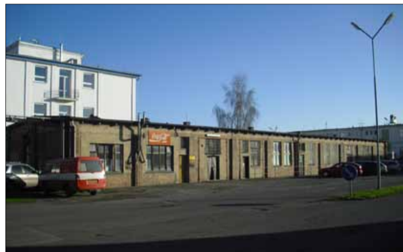
Úložiště písemností před rekonstrukcí.
