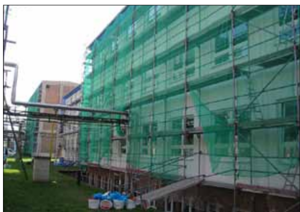
Snímek z průběhu prací na budově GR.
