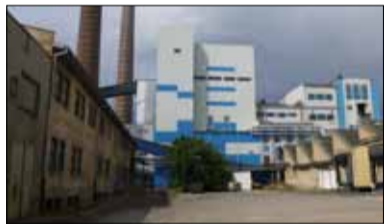
Objekt energetiky po rekonstrukci a výstavbě nové kotelny.
