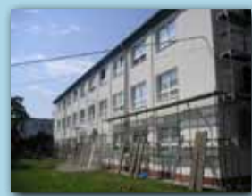
OPRAVY FASÁD JSOU V PLNÉM PROUDU
