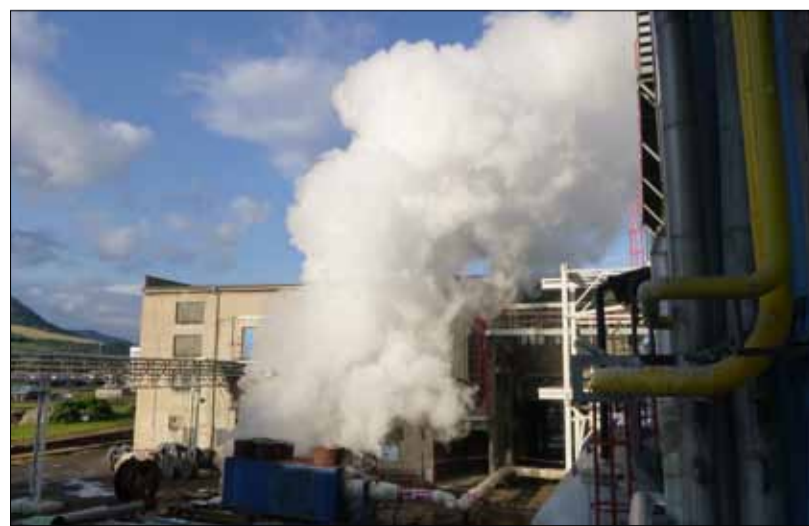
Tlumič hluku páry při profuku parovodů.
