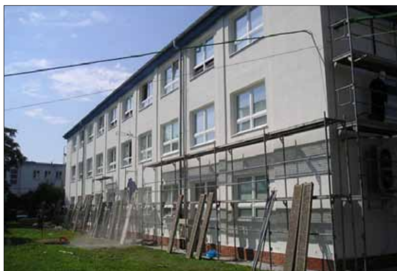
Demontáž lešení po opravě fasády budovy GR.
