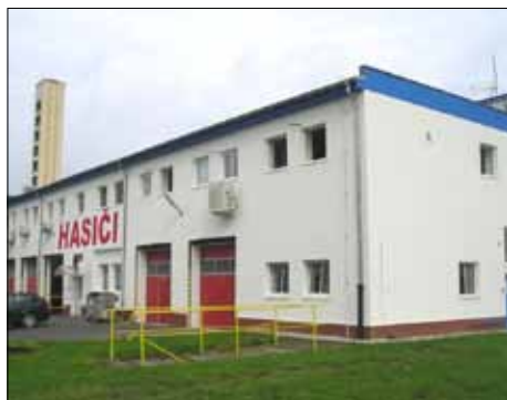
Dokončená oprava fasády budovy OTBS a hasičů.
