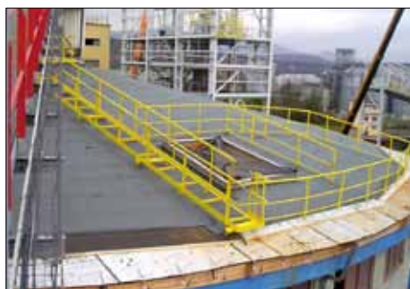
Nová střecha kruhového skladu č. 480 před dokončením.
