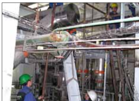
Montáž nového stropu v napáječárně na Energetice.
