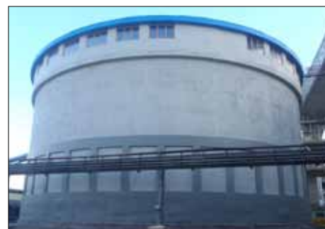
Dokončená rekonstrukce kruhového skladu č. 481.
