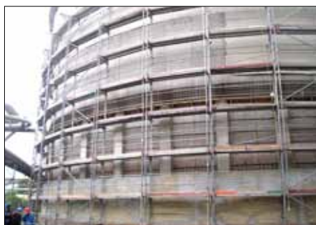
Průběh rekonstrukce nosné výztuže kruhového skladu č. 481.
