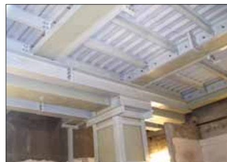
Dokončená oprava stropu v napáječárně na Energetice.
