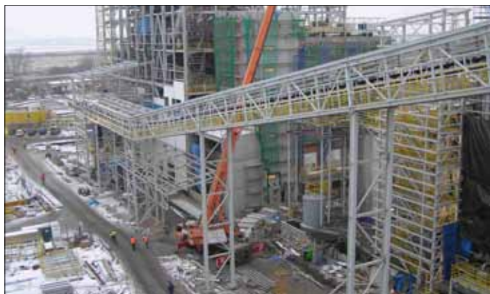
Pohled na staveniště UGL.
