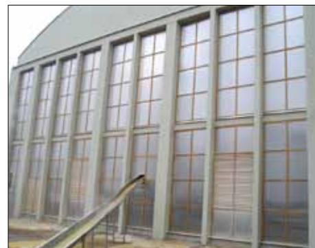
Dokončená sanace fasády haly B v Městci Královém.
