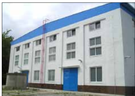
Dokončená fasáda ÚLV - východní strana.
