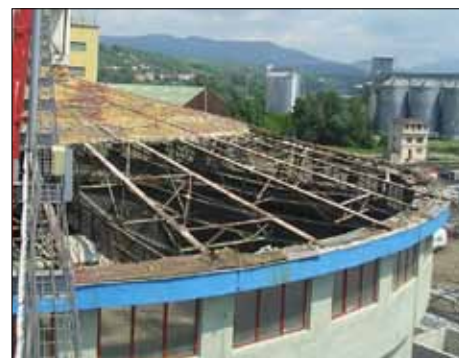
Bourání staré střešní konstrukce kruhového skladu č. 480.
