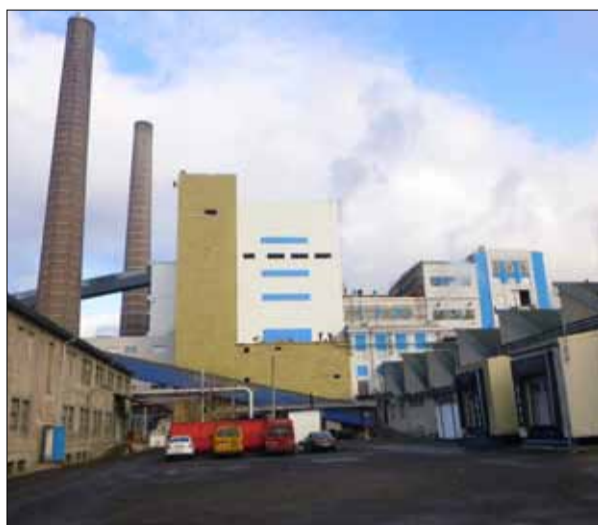
Celkový pohled na stavbu.
