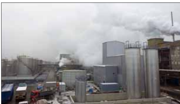
Výhled na stavbu výroby jedlého oleje z třetího patra „Modré budovy PREOLu“.
