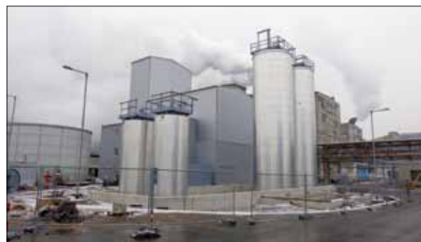
Budova rafinerie při pohledu na východ.
