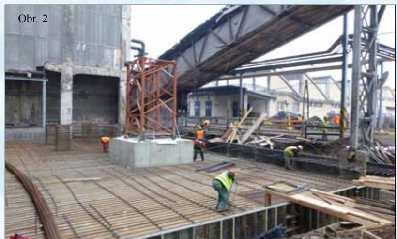
Usazení základu jeřábu a armatura základové desky.
