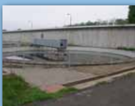
JAK SE CO DĚLÁ - FILTRACE KALŮ
