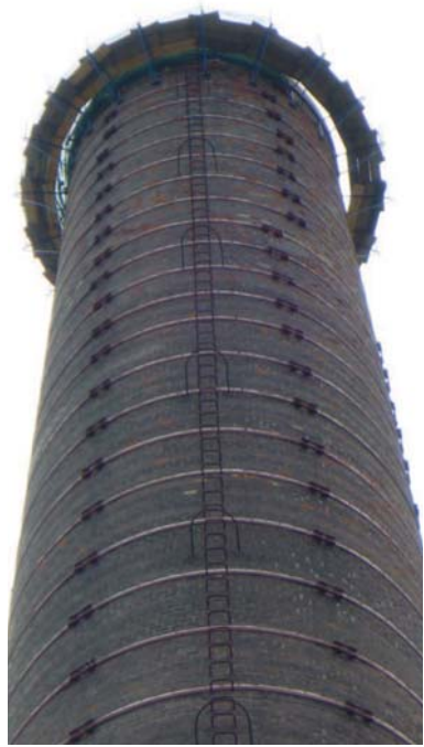
Pracovní plošina na komíně 3303 ve výšce 77 m. Foto: Václav Havlík
