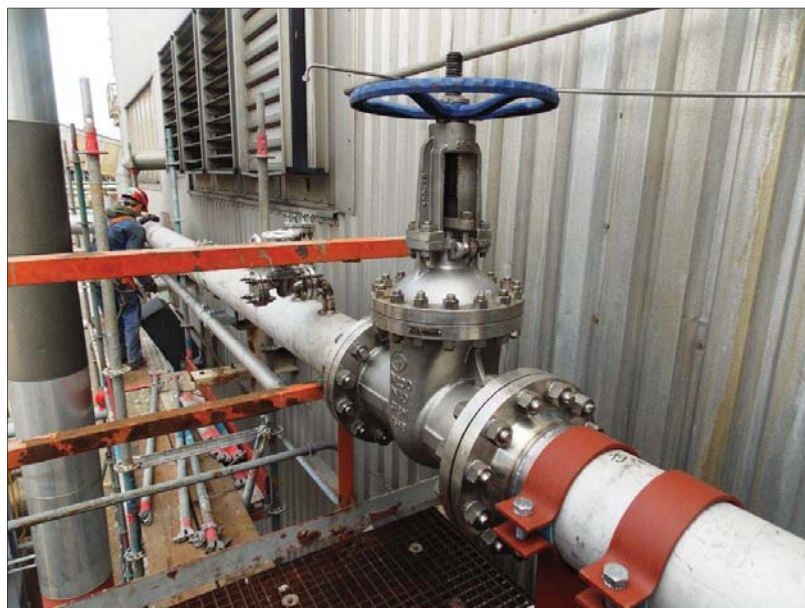
Opravené potrubí plyného čpavku na LAV3.
