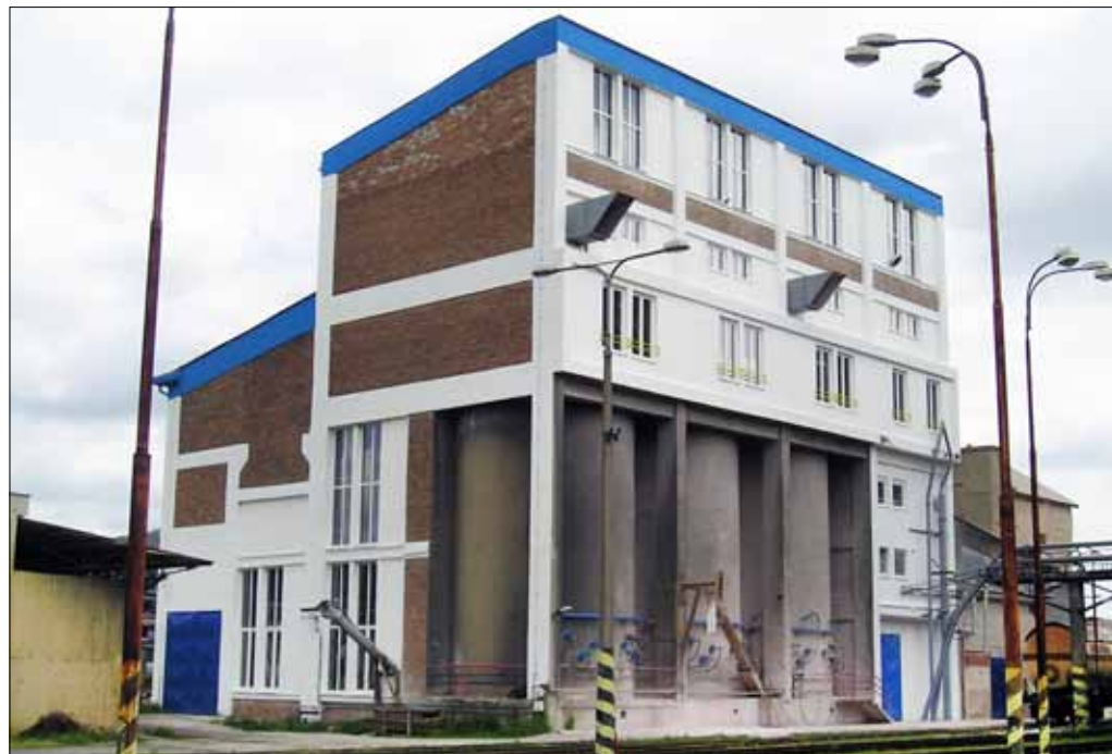
Mlýnice - dokončená oprava k 29. 4. 2013.
