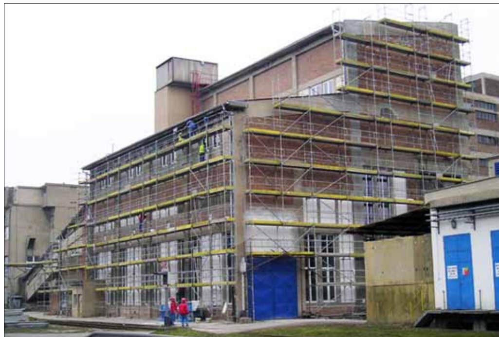
Stav opravy k 29. 3. 2013.
