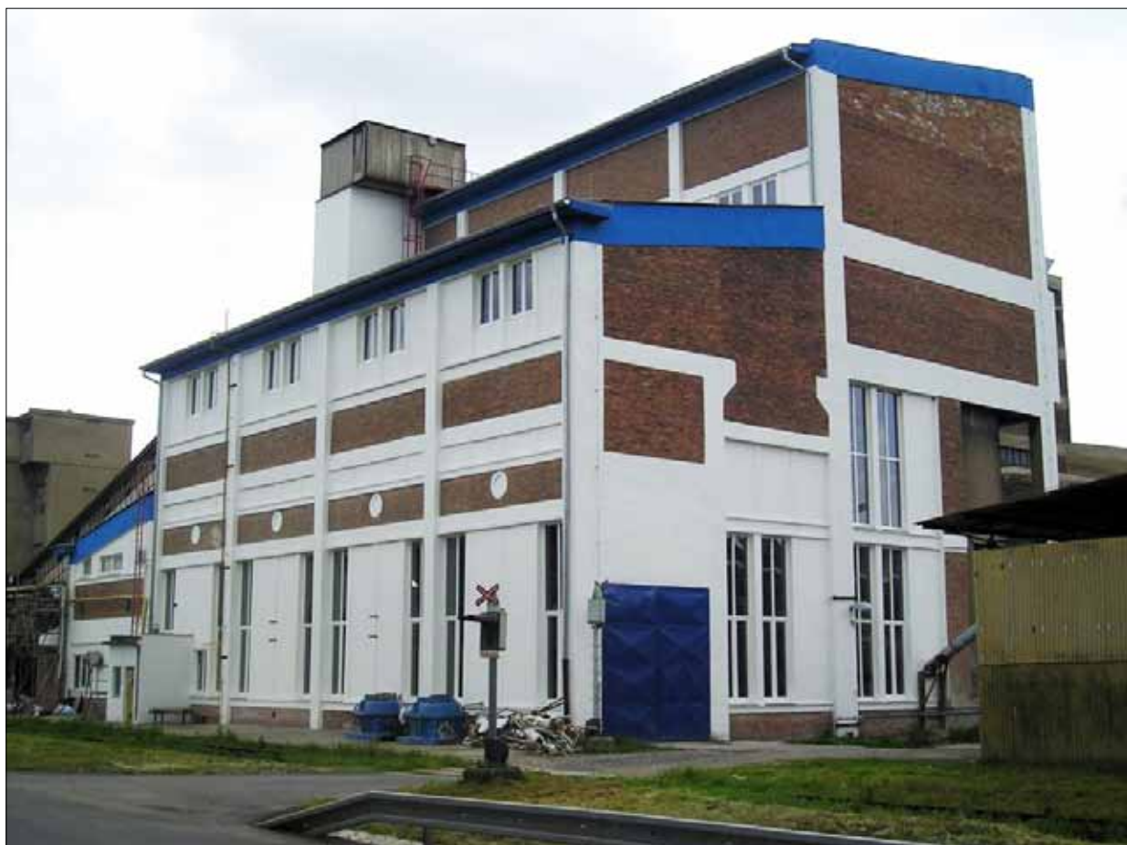
Mlýnice - dokončená oprava k 29. 4. 2013.
