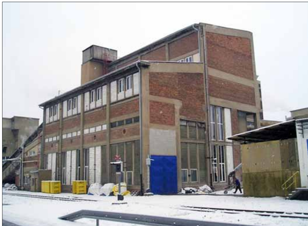
Stav opravy k 13. 12. 2012.
