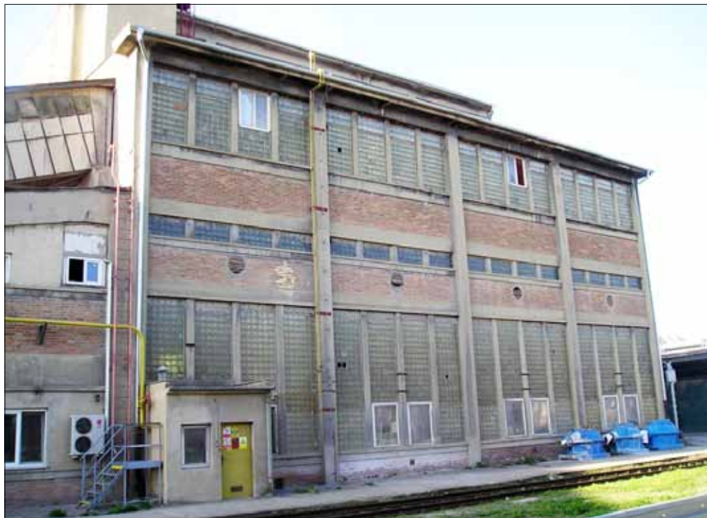
Původní stav - severní fasáda k 5. 4. 2012.
