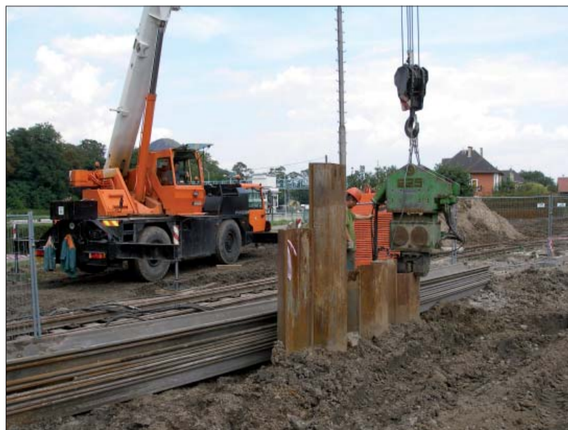
Od června probíhá výstavba podzemní části stabilní protipovodňové stěny v oblasti ČOV. Základ stěny tvoří železobetonové piloty, které jsou postupně doplňovány injektážními vrty. Vytvořená nepropustná clona, zavazaná do podloží v hloubce více než 11 m pod terémem, zamezí možnosti průsaku podzemní vody do tohoto nejnižší položeného území areálu Lovochemie. Foto: Eva Živná
