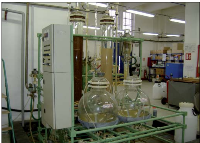
Demistanice slouží k výrobě demineralizované vody na praní perlové celulózy.
