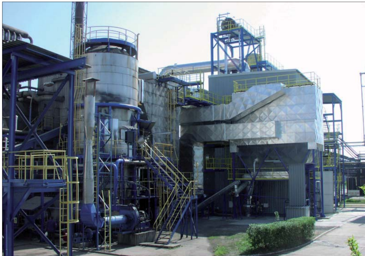
Pohľad na rekonštruovanú spaľovňu nebezpečných odpadov Duslo, a.s.
