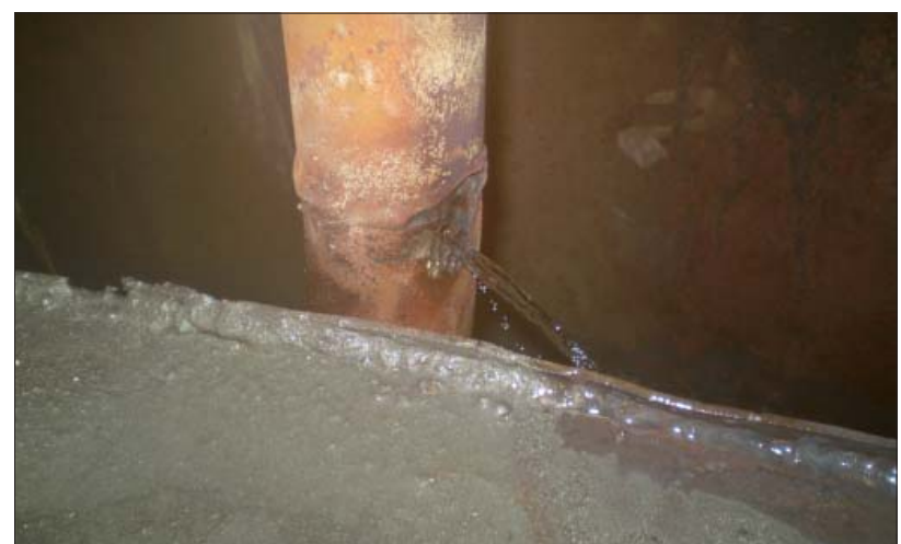
Životnost kotle výrobní KD5 je již pomalu vyčerpána - oprava netěsnosti z 12/2007. Foto: Petr Cermánek
